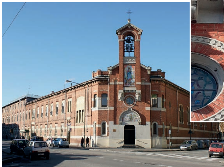
Sopra: La chiesa di San Domenico Savio a Torino.
