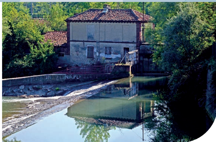
Il canale artificiale della Ceronda a Torino che serviva come fonte di energia per la nascente industria torinese.
