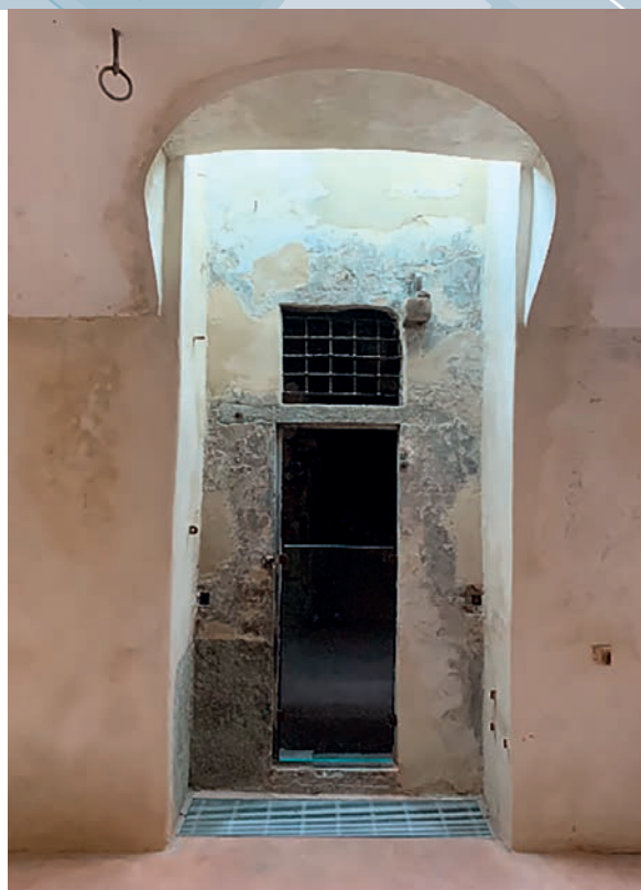
L'accesso al pozzo.
