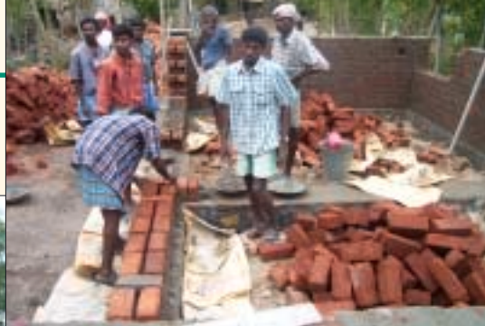
Operai al lavoro per il progetto/casette.
