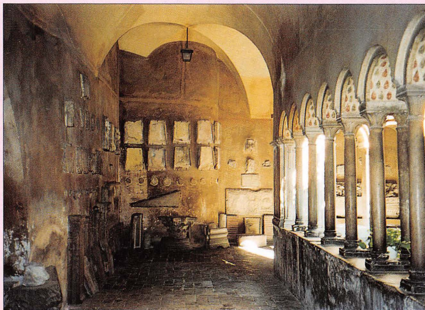
Portico e chiostro medioevale risalente agli inizi del secolo XIII. È avviato un progetto di restauro.
