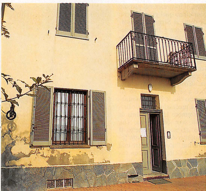
■ La scuola di Montaldo (To) (Foto Pera).
