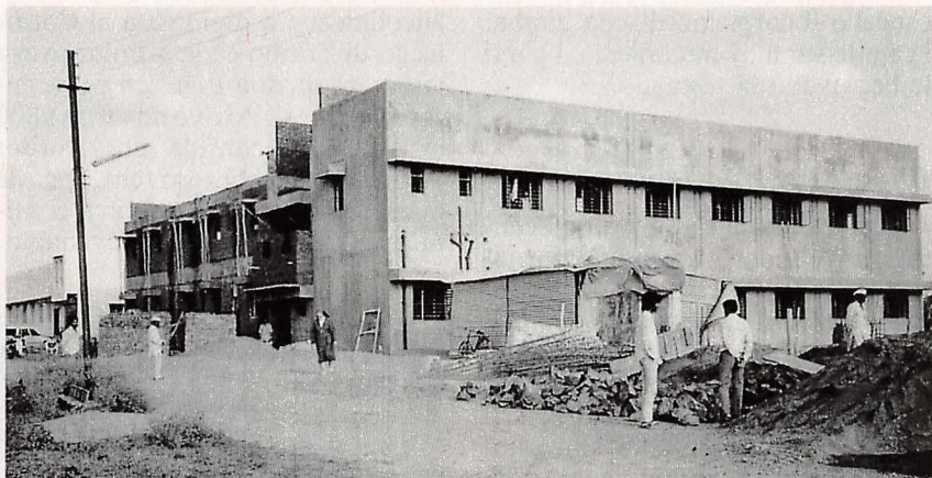
Ahmednagar. L'opera in costruzione.
