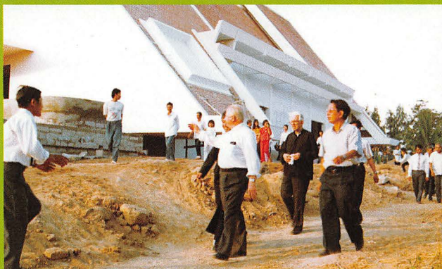
Phước Lộc. Il Rettor Maggiore, accompagnato dall'ispettore don Peter Dê, gira attorno alla nuova chiesa di Maria Ausiliatrice in costruzione. I cattolici del Viet Nam, che non hanno il permesso di costruire scuole o altro, si concentrano sulle chiese: le fanno grandi e belle.
