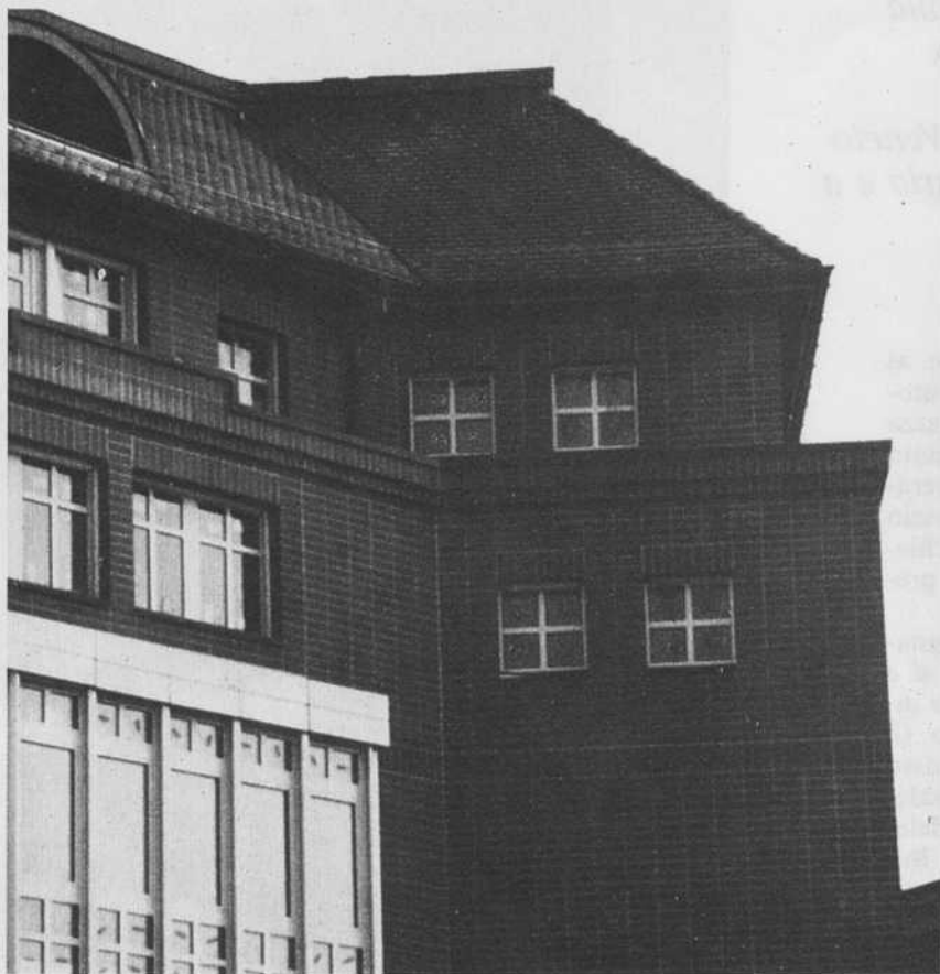
Particolare della facciata della «missione»
