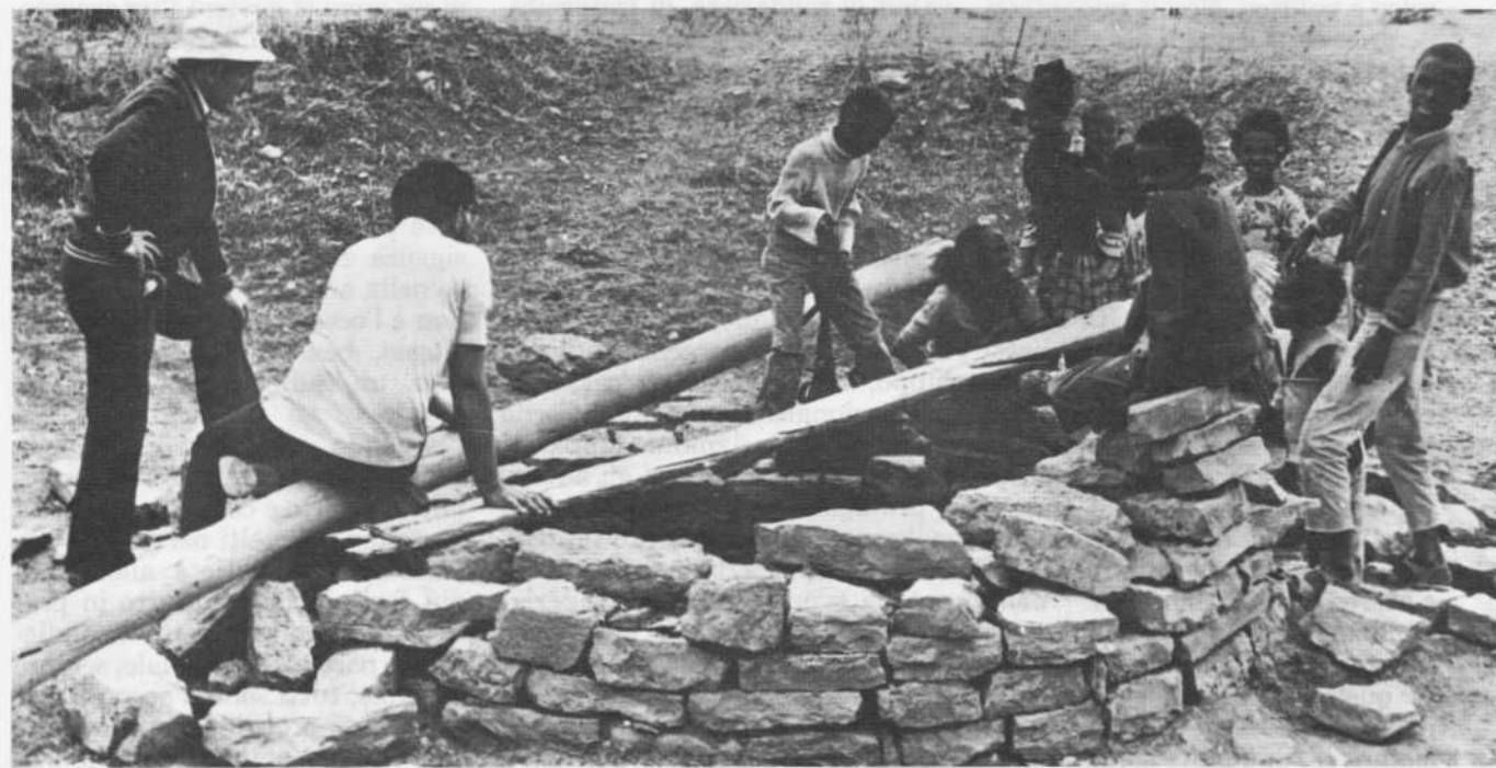
Makallé. Pensando a un nuovo pozzo...
