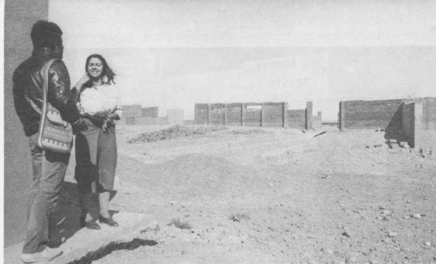
I lavori per la costruzione del santuario in fase di avanzamento.
