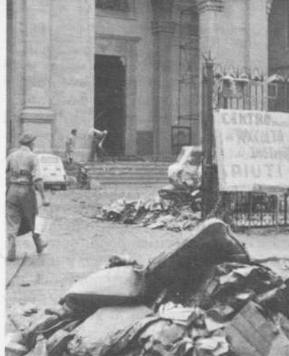
E dopo l'alluvione, la ricostruzione.
