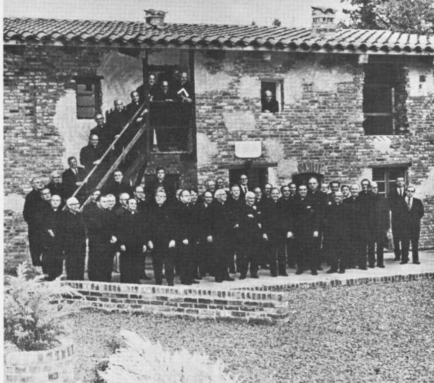
Qui accanto: La « Casa natale » di Don Bosco costruita a West Haverstrow: copia fedele di quella dei Becchi, è fatta con mattoni ricavati da cascine in rovina del Colle Don Bosco e portati in America. Sotto: A Thu Duc, in Vietnam, il Rettor Maggiore è accolto a suon di banda nell'Aspirantato salesiano.
