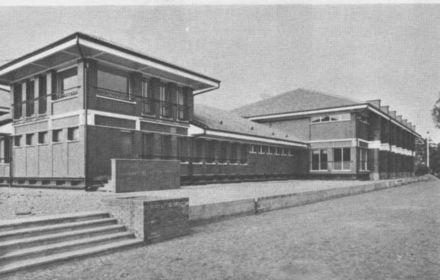
sopra: Veduta parziale dell'edificio attiguo al Campo, che comprende sale da gioco, biblioteca, aula catechistica, sala audizioni, aula di musica • sotto: Le oratoriane, su pattini a rotelle, preparano gare di velocità su pista curva • a destra: Con i campi di pallavolo e quelli di pallacanestro ci sono anche due campi di tennis.
