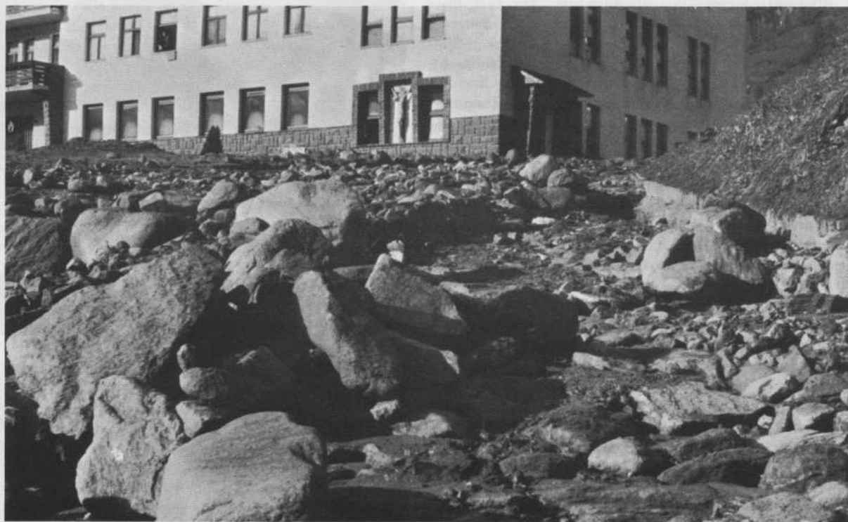
Mezzano (Trento) • L'Istituto Salesiano ha resistito all'urto dei sassi e dei macigni trascinati giù dalla frana.
