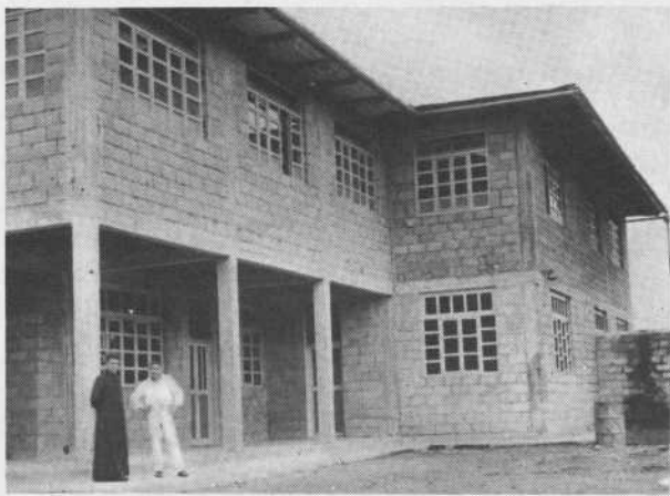
Anche nell'edilizia la civiltà avanza tra i kivari, ma a fatica per la mancanza di strade. Si pensi che il ferro e il cemento di questa costruzione fu tutto trasportato in aereo
