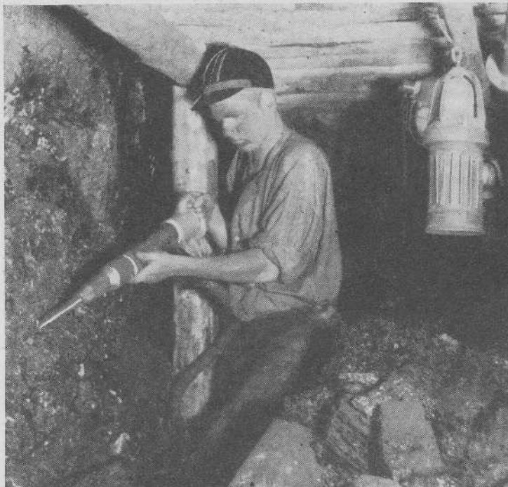
ESSEN (Germania) - Giovane minatore allievo salesiano sul lavoro. Con la perforatrice scioglie il carbone della roccia viva. Per impedire la polvere alla punta non manca mai l'acqua.
