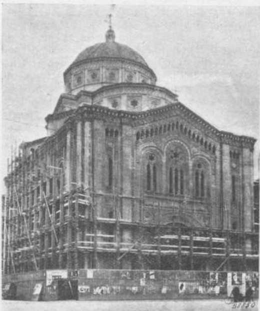
Bologna. — Facciata della Parrocchia del Sacro Cuore allo stato attuale dei lavori.
