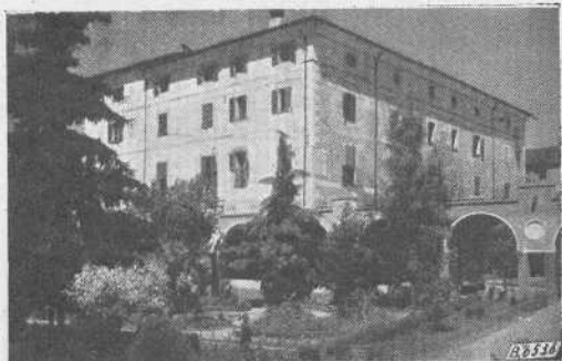
Lombriasco (Torino). — Il vecchio fabbricato.
