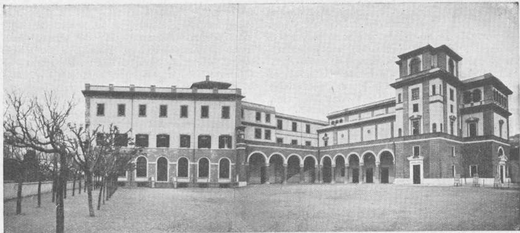
Frascati: Villa Sora. — I nuovi locali dell'Istituto.
