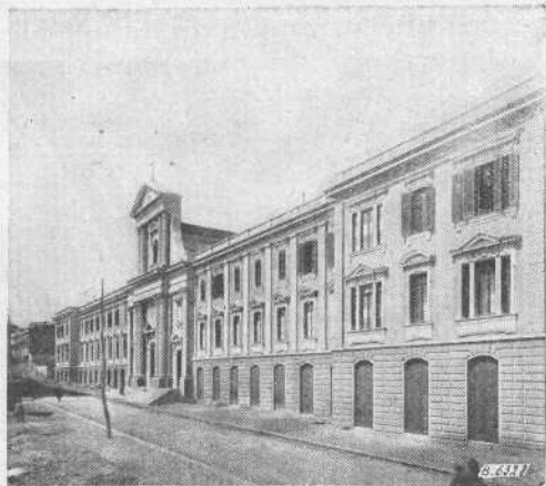
Messina. — Facciata dell'Oratorio Domenico Savio.
