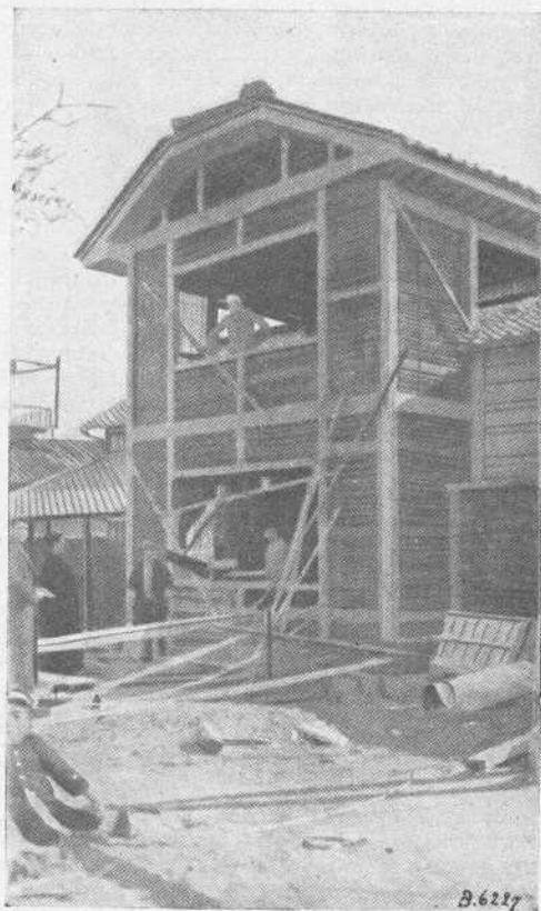
Oita (Giappone). — Asilo infantile in costruzione.
