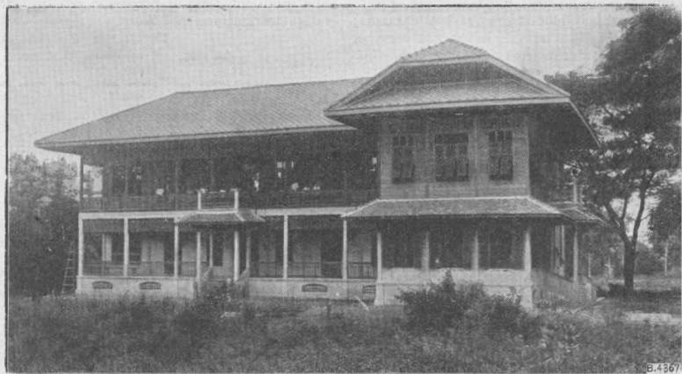
Ban-Pong. — Il nuovo edificio scolastico.
