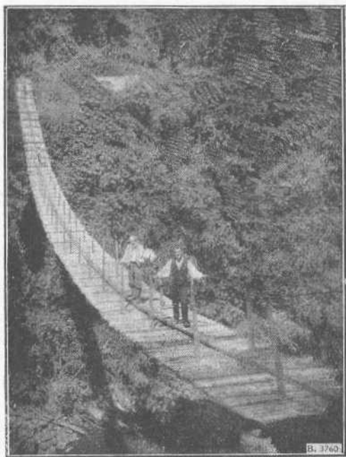
Mendez. — Ponte sospeso sul fiume Namangosa. Opera salesiana: lungh. m. 86, alt. m. 48, largh. m. 6.
