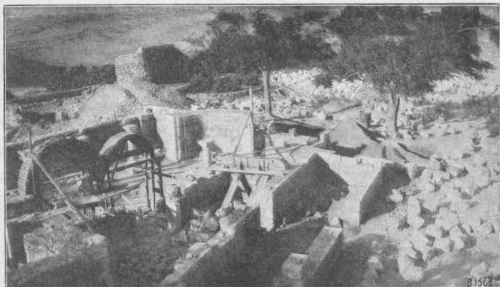
Il "Martyrium", di S. Stefano (sfalo dei lavori in settembre).
