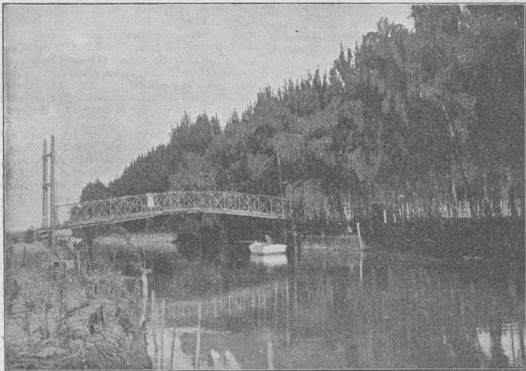
Fortin Mercedes (Palagonia) - Ponte costruito dai nostri su un braccio del Rio Colorado.
