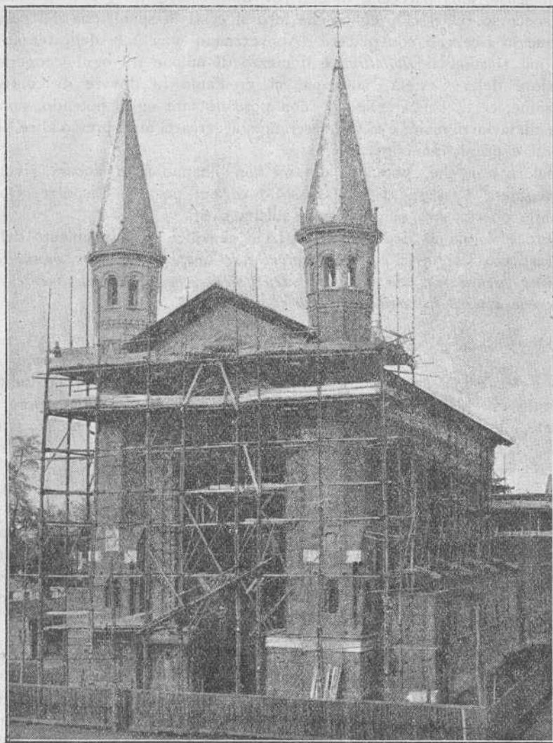
Il Tempio di Gesù Adolescente in costruzione a Torino, in Borgo S. Paolo.
