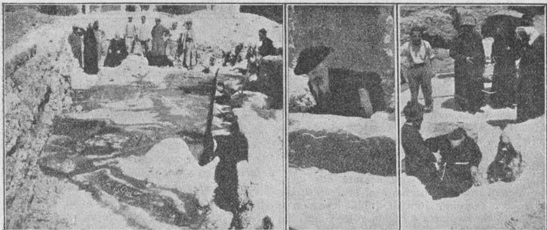
Veduta generale degli scavi.
