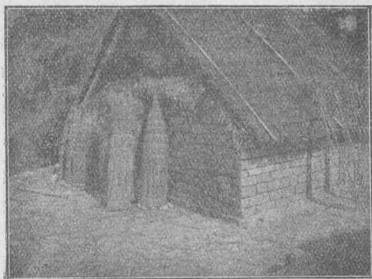
ASSAM. — Capanne di granito e di bambù.
