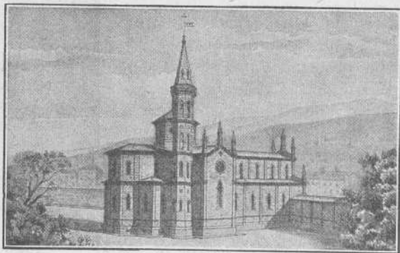
Idem — Prospetto esterno (di fianco).
