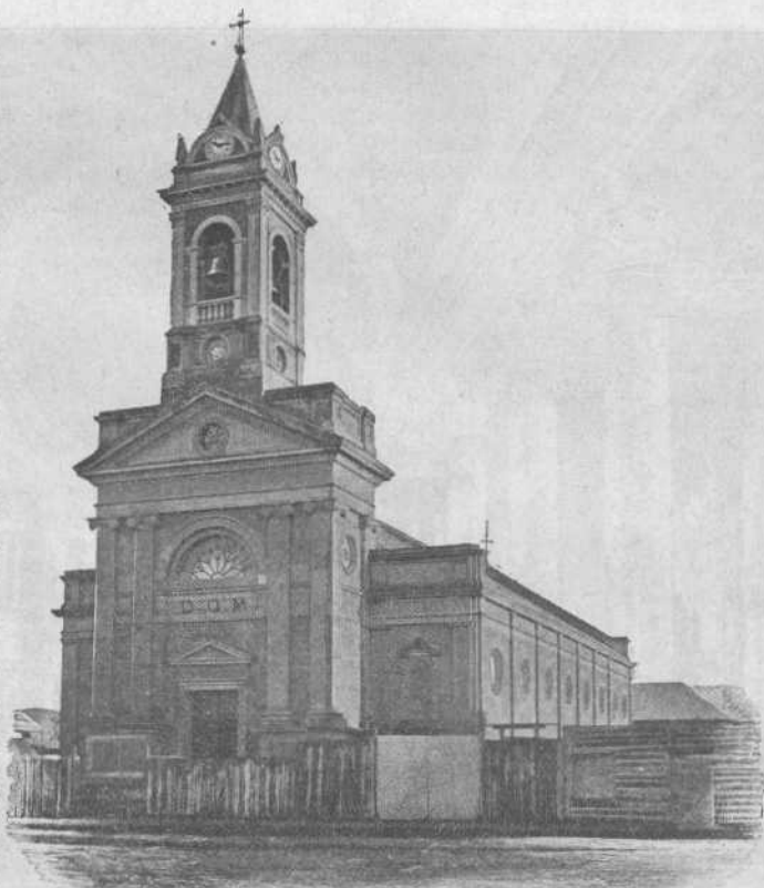
Facciata della nuova Chiesa di Puntarenas.
