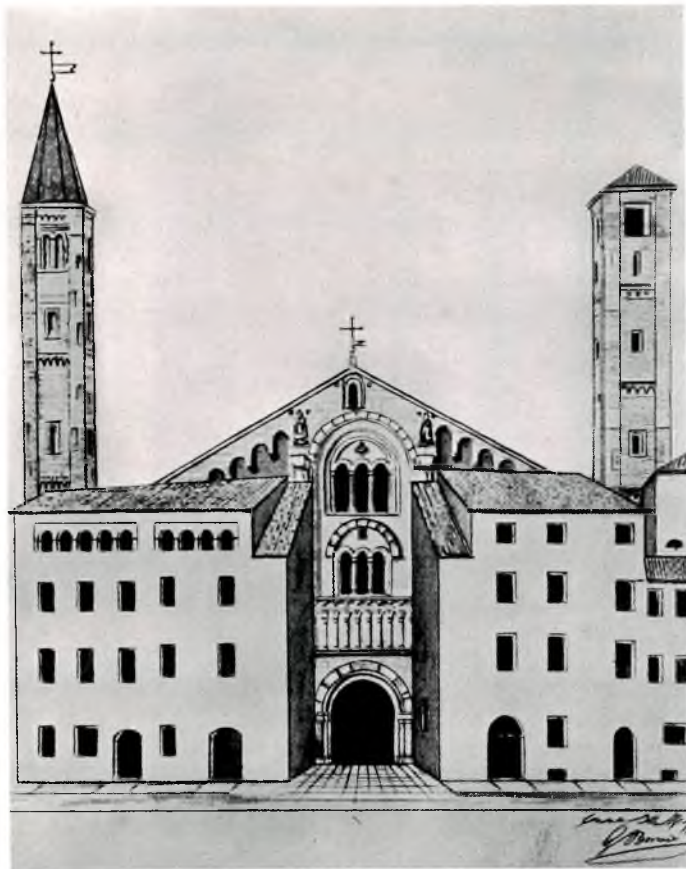
Fig. 54. La facciata della Cattedrale di Casale prima dei restauri di Mons. Calabiana. Si notino le case dei canonici (!) addossate alla facciata (Da Baiano, L., S. Evasio V. e M.).
