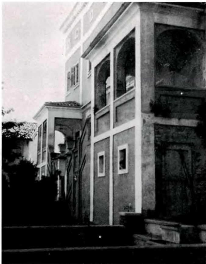
Fig. 35. Il Castello dei Merli come è attualmente. Foto L.D.
