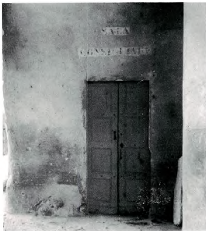
Fig. 32. La porta che immetteva nella sala di Consiglio del vecchio municipio di Ponzano. Foto L.D.
