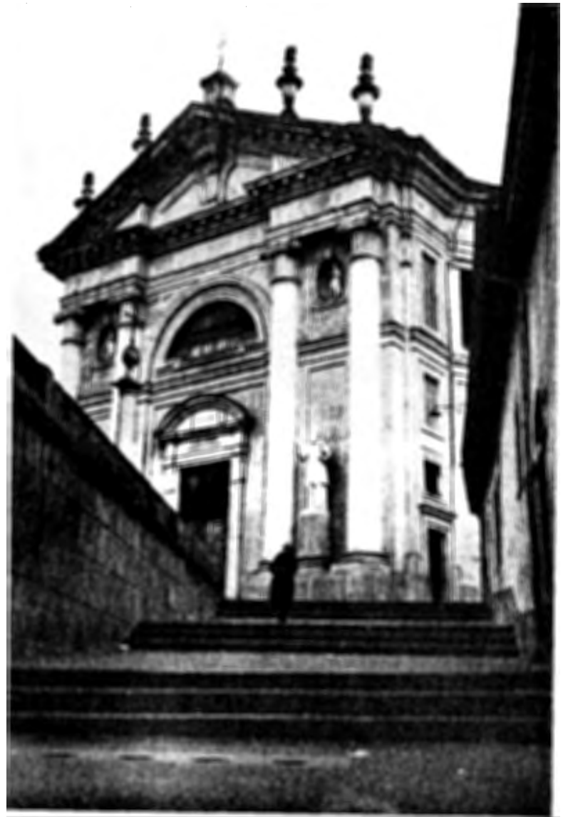
La chiesa parrocchiale di Cumiana (attualmente in riparazione).
