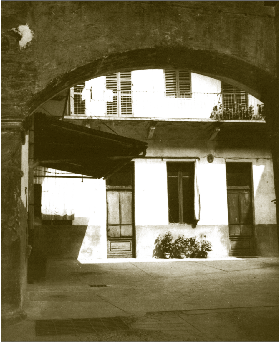
Fig. 20 - Chieri, scuola comunale, edificio nel cortile rustico: il locale a piano terra era adibito a cappella per la Congregazione, al primo piano erano sistemate le aule di umanità e retorica.
