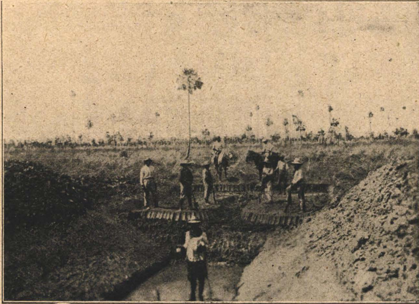
Scavo di un tayamar nel « Ciaco » per la raccolta e conservazione dell'acqua.
