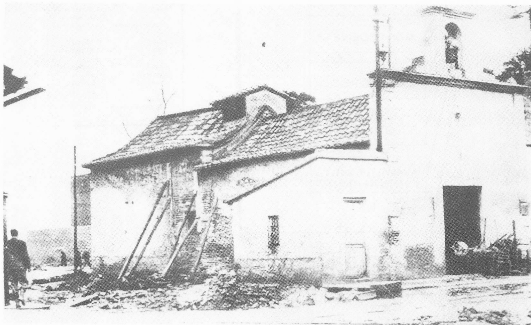
La humilde parroquia de Nazaret, apuntalada, amenaza con derrumbarse después de sufrir el azote de la inundación. Don Marcelino vuelca en ella, en sus feligreses, la preferencia del alma
