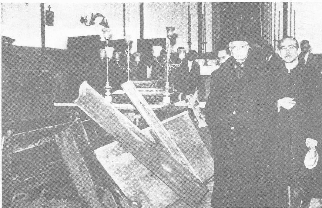
El Arzobispo de Valencia, recorriendo los barrios más afectados por la inundación, llega a la destrozada parroquia de San Juan Bosco. Desolación y ruinas
