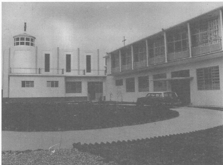
Nueva sede del Noviciado en San Antonio de los Altos (1963).
