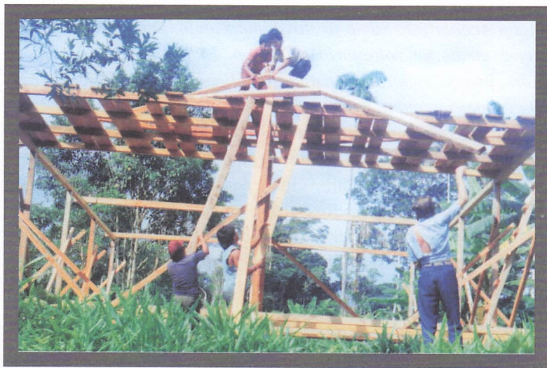
1988 - Costruzione casa a Wasak'entsa
