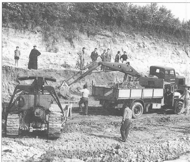
14 maggio 1959: Don Giuseppe Celi, "il Direttore dei lavori", segue le grandi opere di sbancamento di parte della collina, al fine della realizzazione del bellissimo impianto sportivo di calcio, che sarà ultimato ed inaugurato nel 1926
