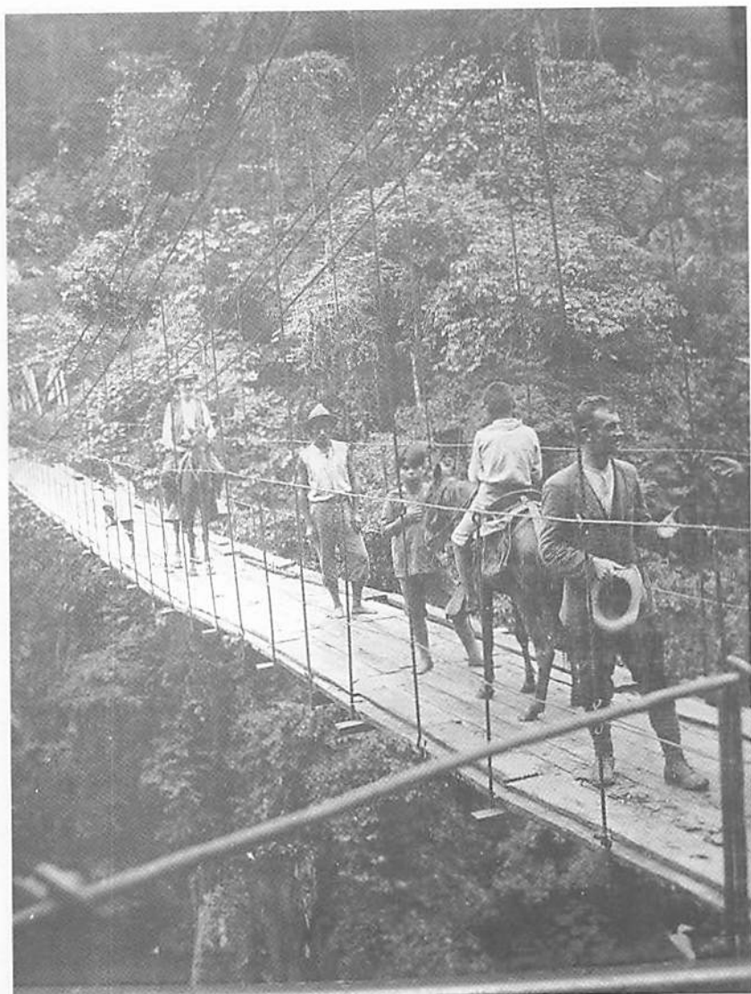
Figura 26. El puente Guayaquil con Jacinto Pankeri a caballo. Su construcción terminó en 1932 (af-cgs).
