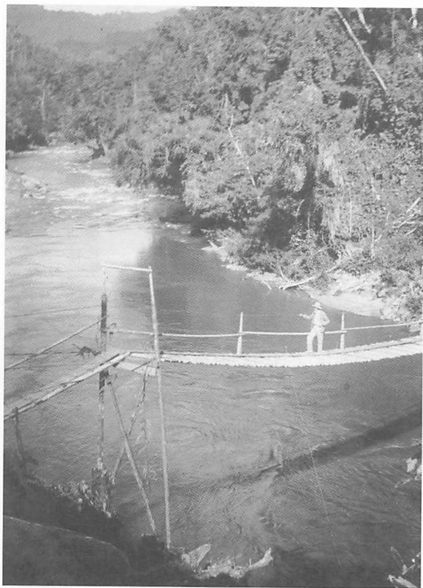
Figura 29. Méndez, pasarela sobre el río Paute, construida por Pankeri (af-cgs).
