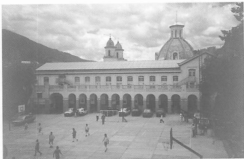
Figura 38. El Colegio Don Bosco en Quito (La Tola) y la iglesia de María Auxiliadora, proyectados y construidos por Jacinto Pankeri. 1997 (FAB).
