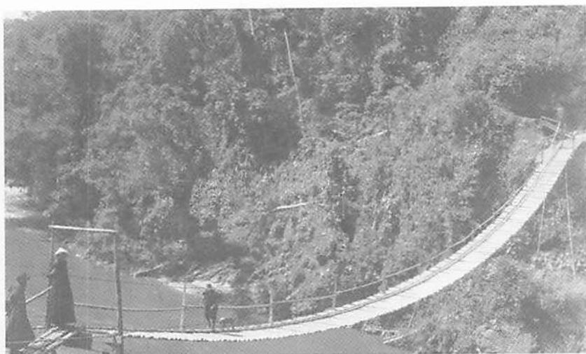
Figura 30. Otra vista de la pasarela sobre el río Paute (af-cgs).
