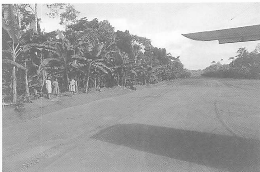
Figura 58. Pista de aterrizaje de tierra apisonada en Wasak'entsa (fEL).
