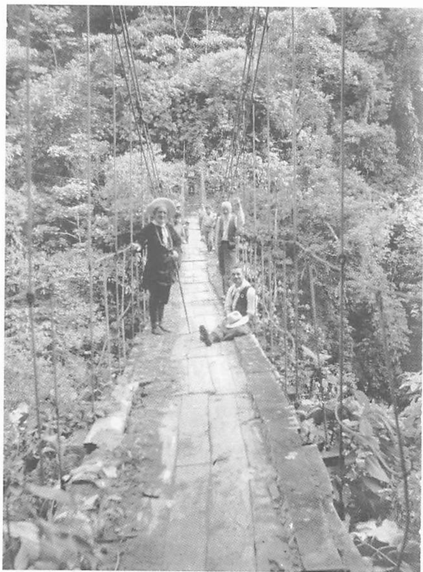
Figura 27. Méndez: el puente Guayaquil sobre el río Paute. Pankeri está apoyado al pasamano, en el centro del puente (af-cgs).
