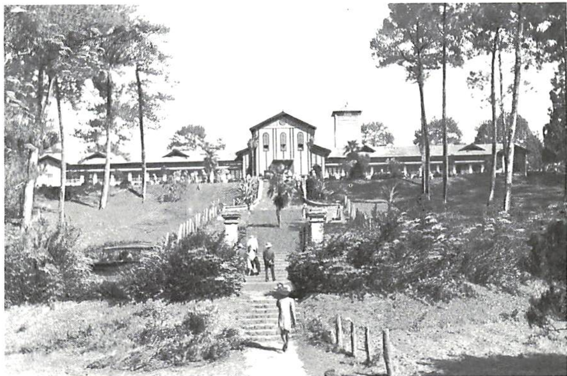
Shillong: Our Lady's House , sede centrale della missione salesiana in India. Anno 1928.
