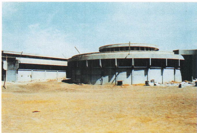
La moderna clinica al centro del grande complesso con i vari reparti.
