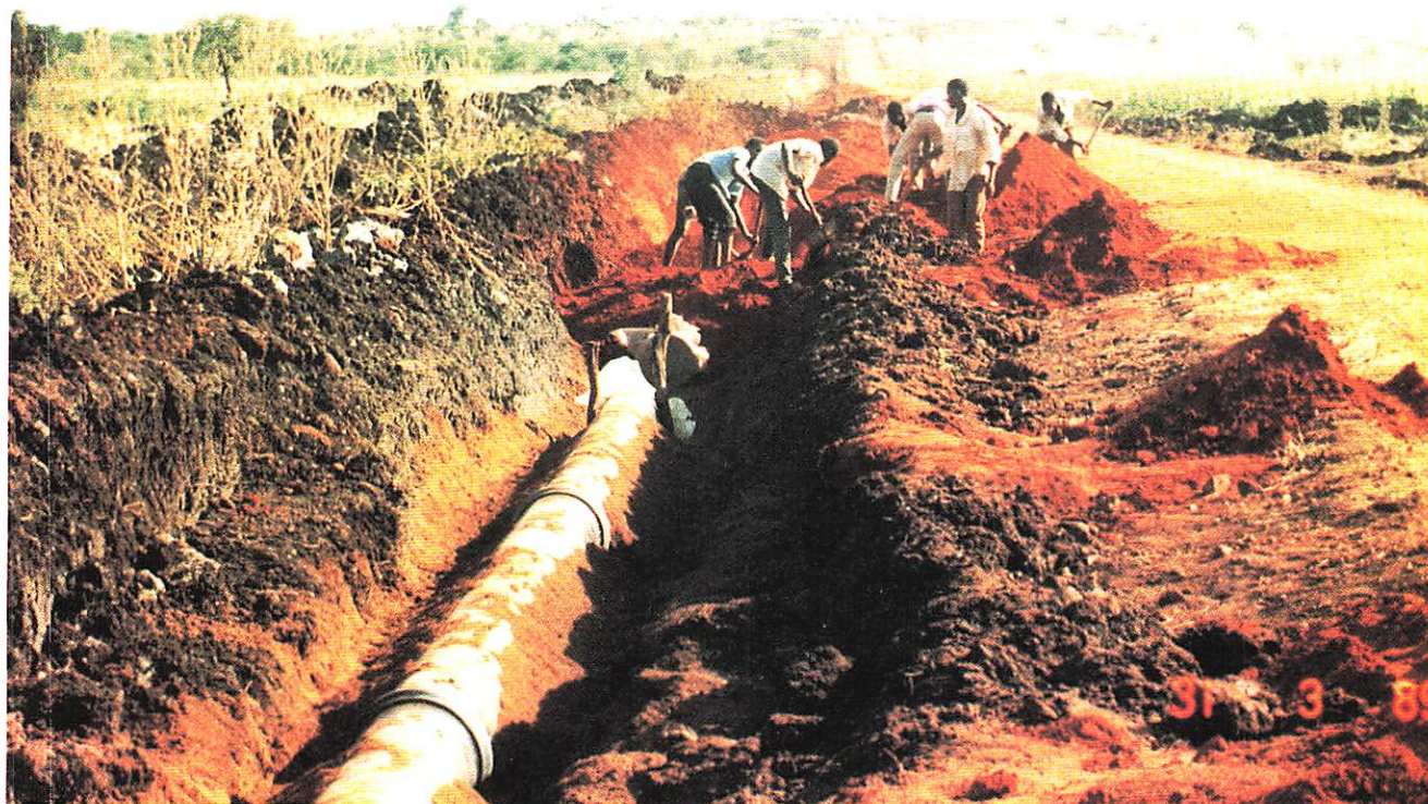
Posa dei tubi.
