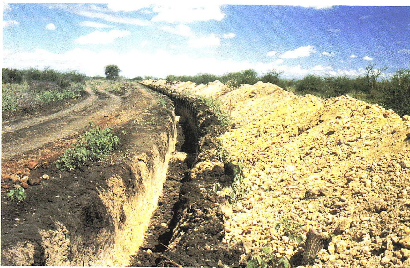
Scavi per le tubazioni.
