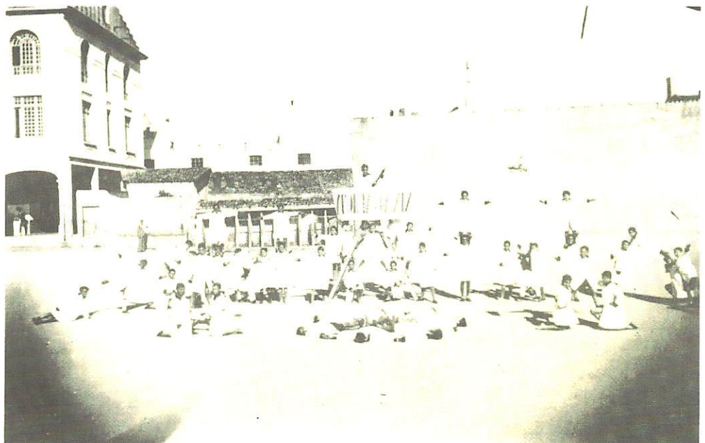
Cuadro plástico con motivo del reparto de premios del curso 1935-36. Al fondo la huerta y los servicios higiénicos en el terreno en el que se construirá más tarde el nuevo teatro. Año 1936.
