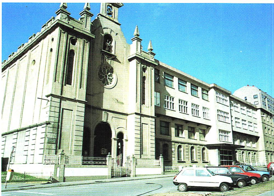
Fachada principal del Colegio Salesiano "San Juan Bosco"
