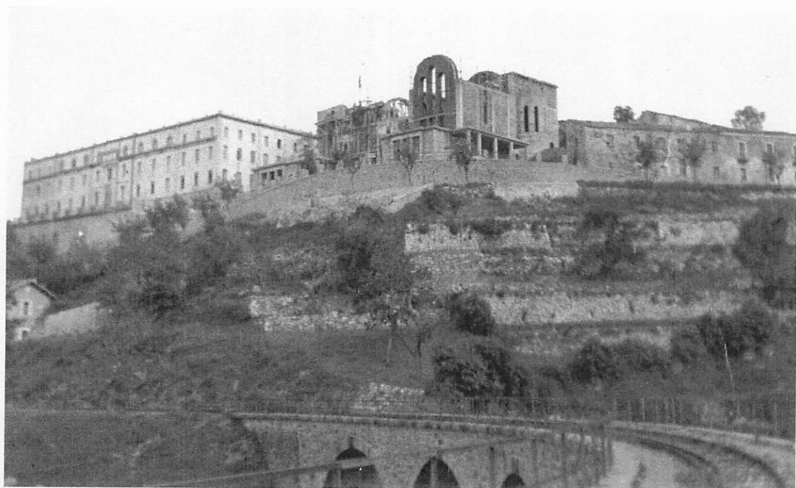
Lanusei. Il Tempio a Don Bosco in costruzione
