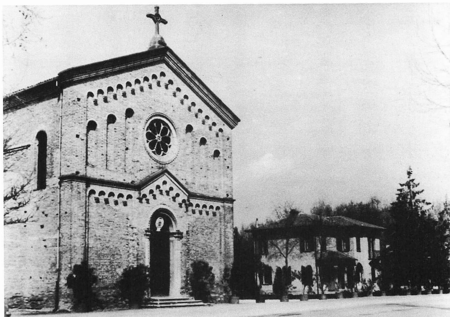
La facciata della Chiesa prima della sistemazione.
