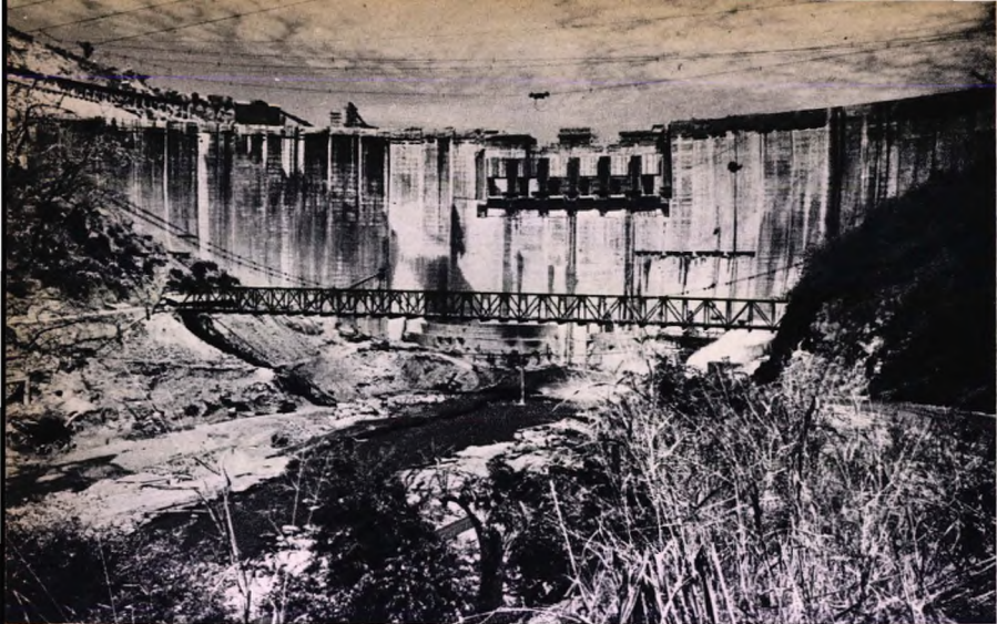
La diga verso il termine dei lavori.
