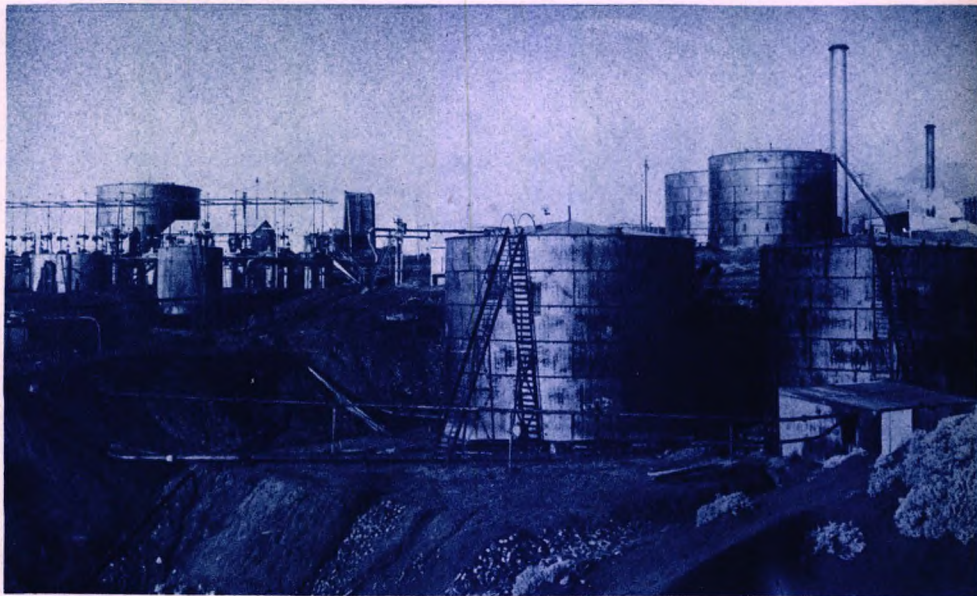
(sotto) COMODORO RIVADAVIA - Giacimenti di petrolio. Impianti di raffinerie e serbatoi ausiliari.
