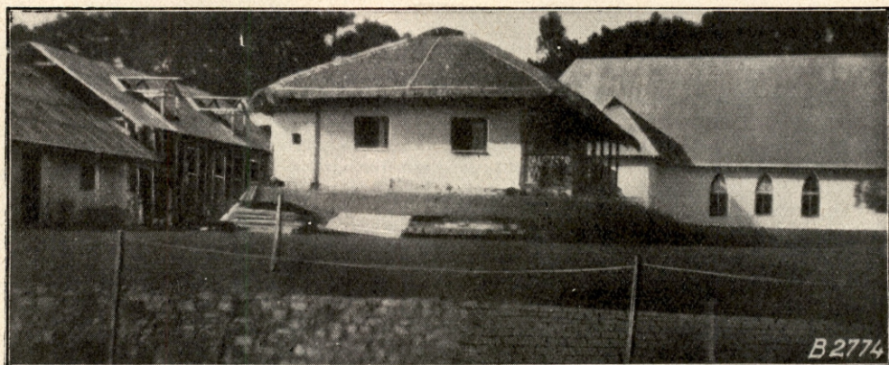
JOWAI (India). = Chiesa, missione e orfanotrofo in costruzione.
