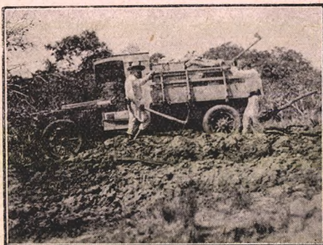
Tra le asprezze del terreno.
