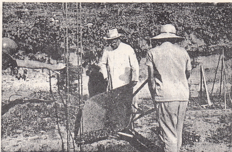
Ksiądz Piotr Stolarz nadzoruje prace budowlane w Valera
